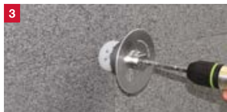
3 Wkręcenie za pomocą urządzenia ejotherm STR-tool 2GE: automatyczne zagłębienie łącznika (bez frezowania, bez brudu)
