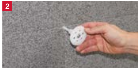
2 Włożenie zmontowanego łącznika w przygotowany otwór montażowy
